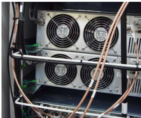
Equip & Rack bonding
